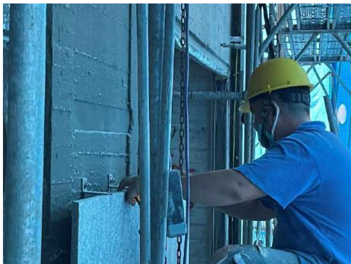
1F~2F外牆石材施作
