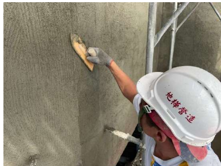
10F牆面打底施作
