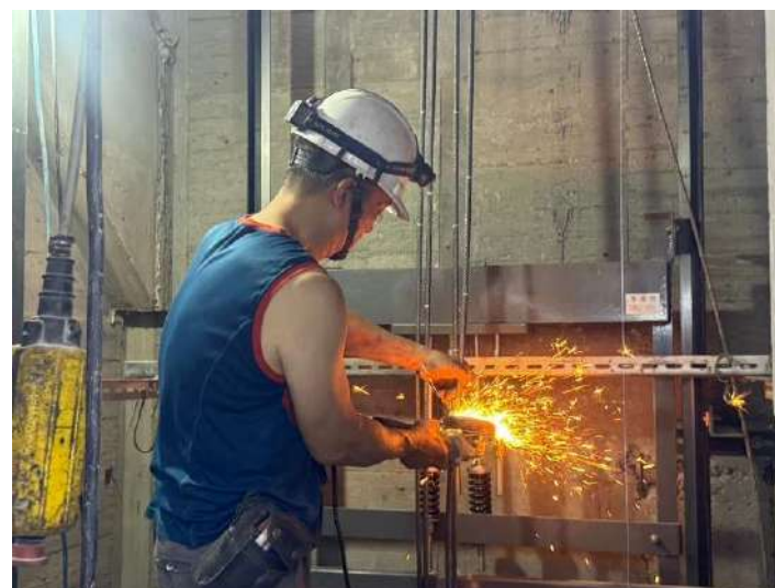
電梯設備安裝
