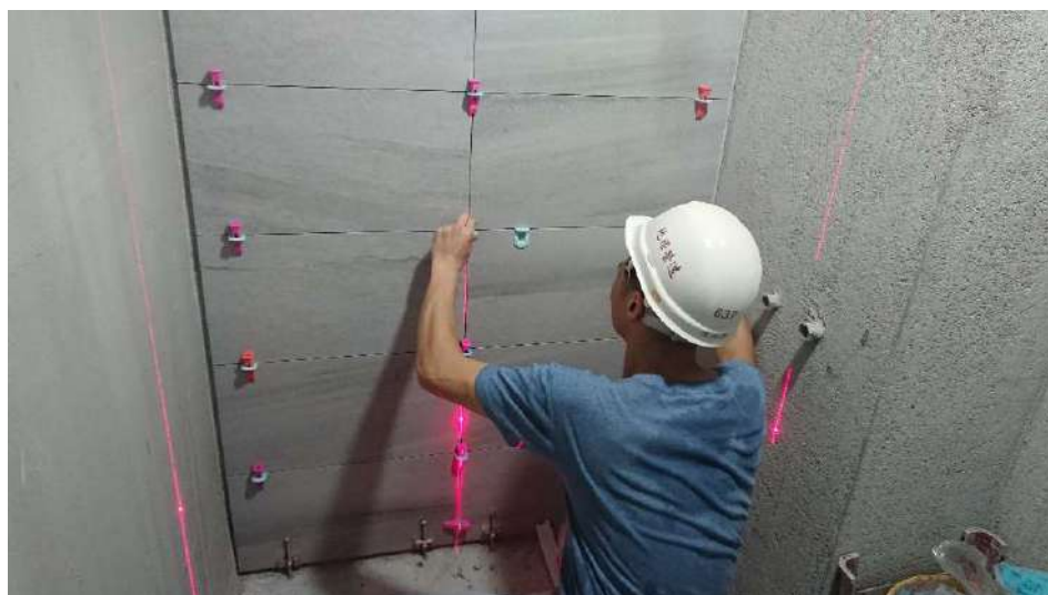
4F廁所牆磚施作
