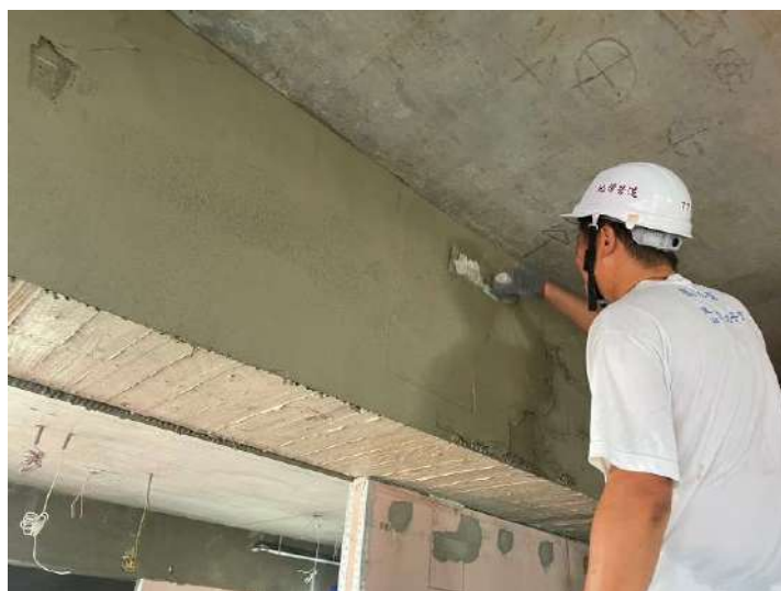
10F內牆打底施作
