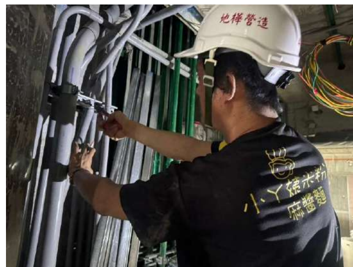
梯廳幹管配管
