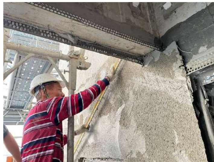
11F外牆打底施作
