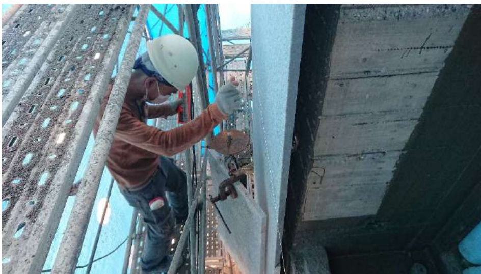
1F~2F外牆石材施作
