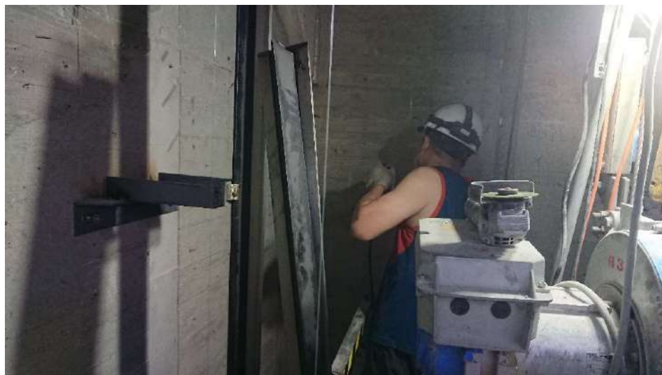
電梯設備安裝
