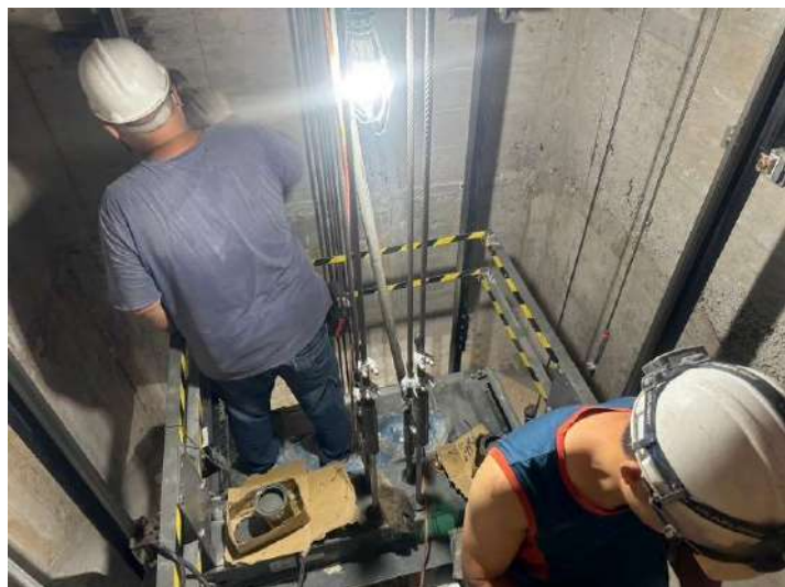
電梯設備安裝
