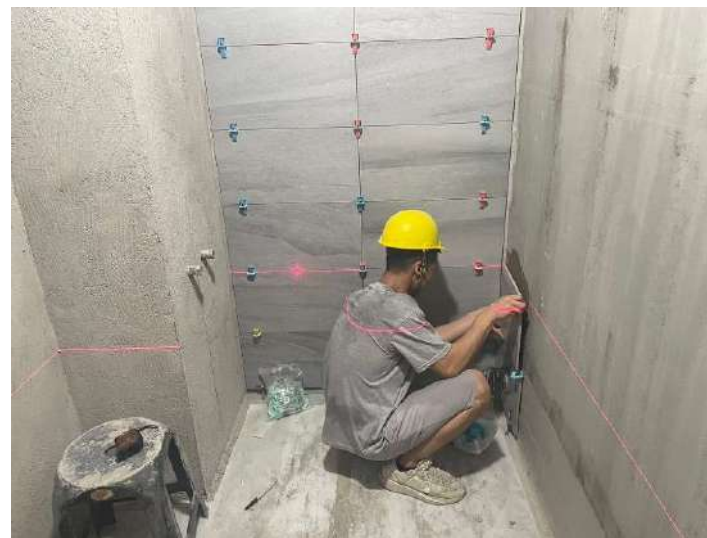
4F廁所牆磚施作
