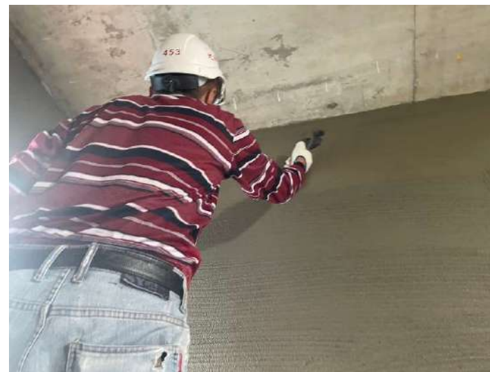
RF室內打底施作
