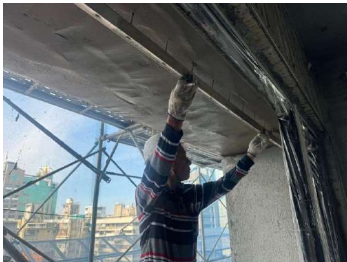
10F外牆打底施作
