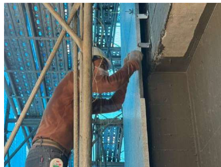
1F~2F外牆石材施作
