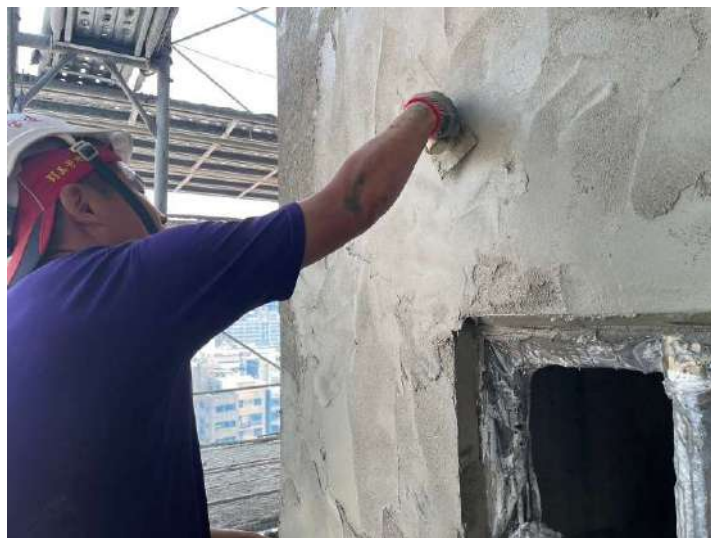
11F外牆打底施作
