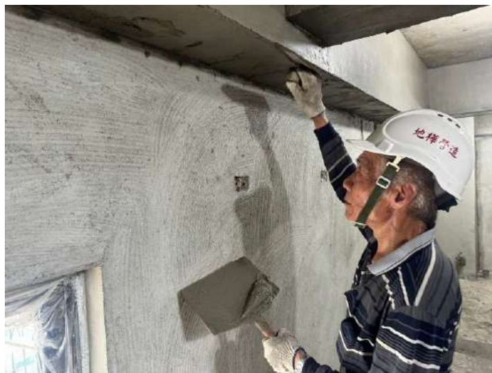
RF室內打底施作
