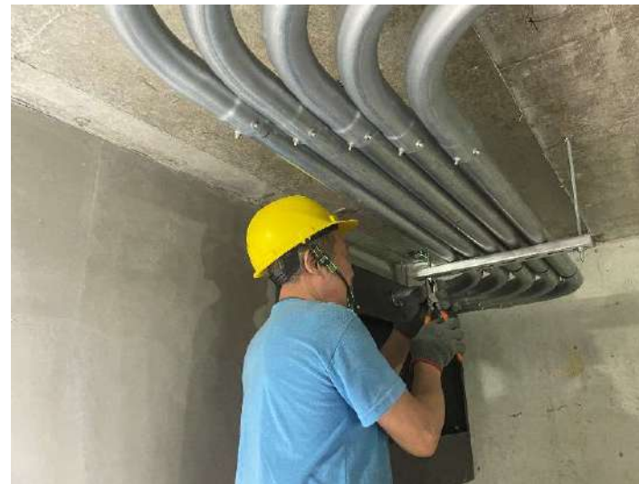
B1F電氣幹管配管
