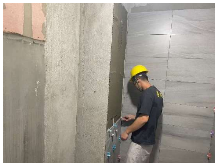
4F廁所牆磚施作
