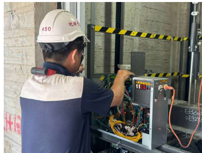
電梯設備安裝
