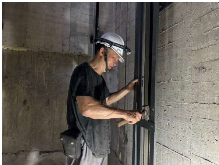
電梯設備安裝
