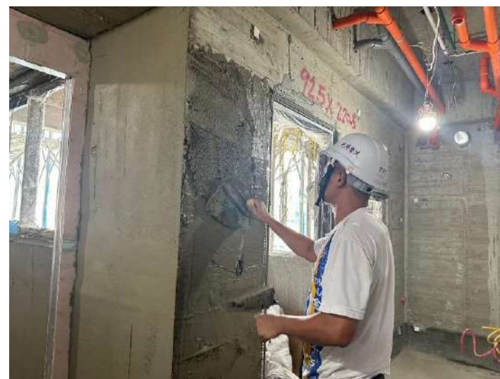
10F內牆打底施作
