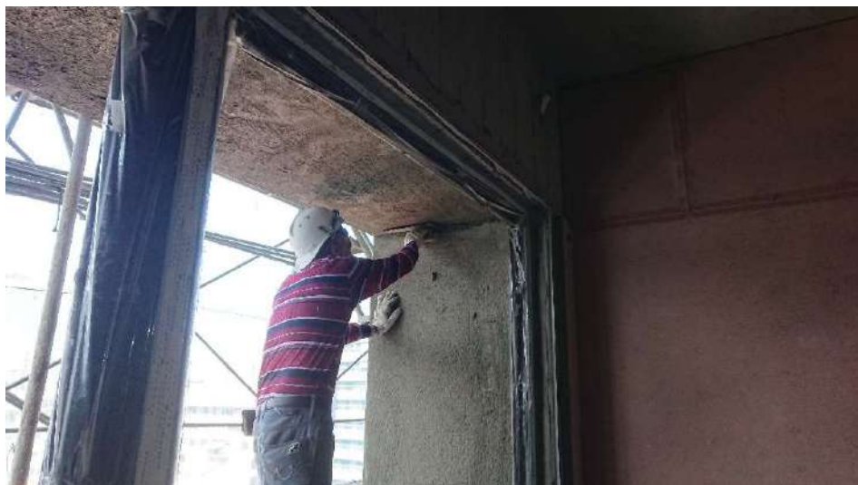
10F牆面打底施作
