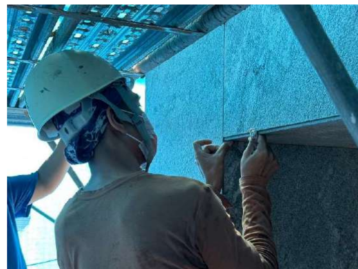
1F~2F外牆石材施作
