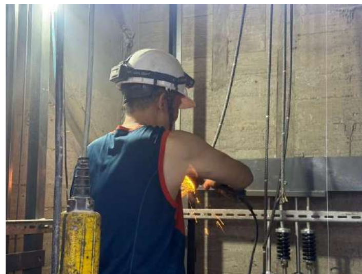
電梯設備安裝
