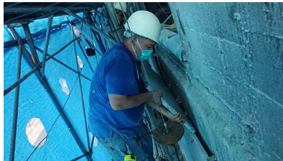
1F~2F外牆石材施作
