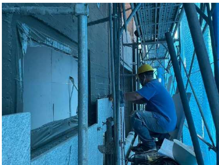
1F~2F外牆石材施作
