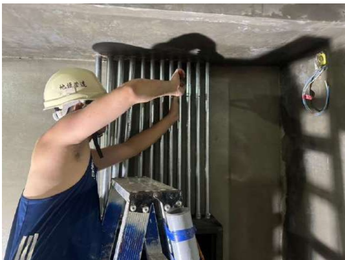
B3F電箱配管拉線
