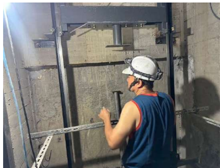
電梯設備安裝
