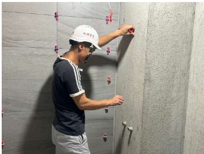
4F廁所牆磚施作
