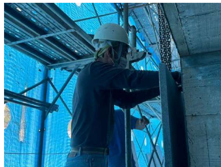
1F~2F外牆石材施作
